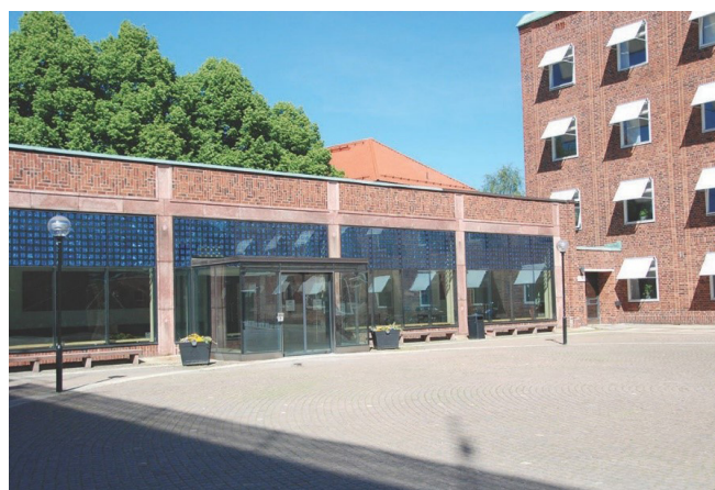
Semitransparenta solceller integrerade i glas (KTH Auditorium). Bild: Paula Femenias
