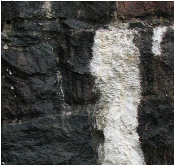
Figur 33-34. Om kalkbruk blir instängt i en fuktig mur och långvarigt exponeras för vatten löses kalken upp. Här är ett exempel från Örgryte nya kyrka där murbruket i bakmuren lösts upp bakom den täta ytan med fasadtegel och cementbruk samt ett exempel från Bohus fästning där kalken i murbruket har lösts upp bakom den täta cementfogen och avsatts på ytan.
