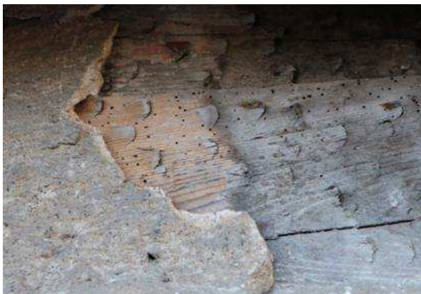
Figur 7. Råhuggning på hammarbandet på ett bulhus. Foto: Sofie Nygren
