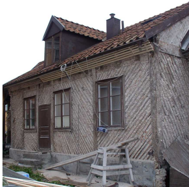
Figur 3. Reveterat bulhus i Visby, under omputsning 2003. Här syns inre ribbningen bevarad och mellan ribborna ligger kalkputs med tegelskåvor instuckna i bruket. Foto: Kristin Balksten
