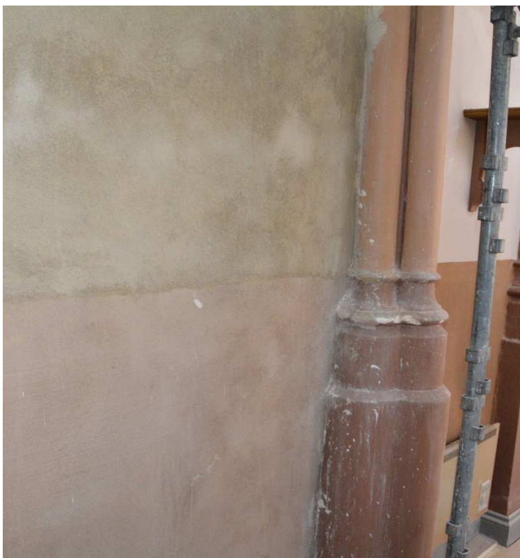
Figur 22-23. Den färdiga putsytan är här utförd med infärgat kalkbruk av NHL3,5 1:1,5 0-4 mm, med en närliggande kulör som färdig avfärgad yta. Foto: Kristin Balksten
