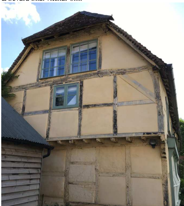
Figur 17. Ett gammalt korsvirkeshus tillhörandes Marianne Suhr med hampakalk som fyllnadsmaterial i korsvirkessommen. Foto: Kristin Balksten
