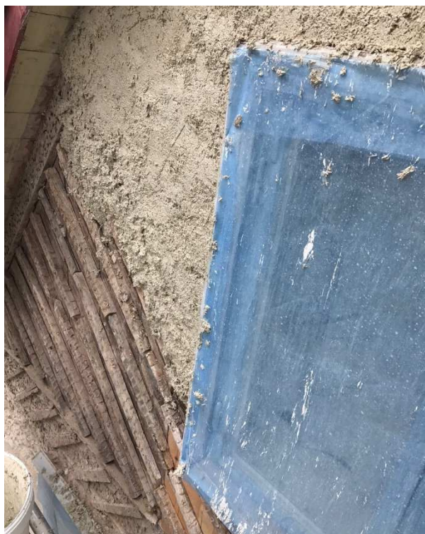
Figur 8. Hampakalk under påförande. Hampakalken bygger så bra att det räckte med ett påslag som fyllde mellan och utanpå ribborna. Foto: Anna Donarelli
