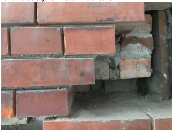
Figur 33-34. Om kalkbruk blir instängt i en fuktig mur och långvarigt exponeras för vatten löses kalken upp. Här är ett exempel från Örgryte nya kyrka där murbruket i bakmuren lösts upp bakom den täta ytan med fasadtegel och cementbruk samt ett exempel från Bohus fästning där kalken i murbruket har lösts upp bakom den täta cementfogen och avsatts på ytan.
