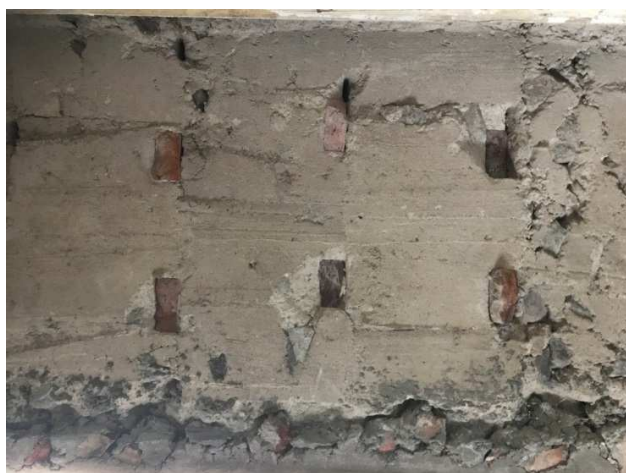
Figur 12. I gjuthuset Stora Sörgården i Utby syns ännu brädornas avtryck i väggarna. Foto: Kristin Balksten
