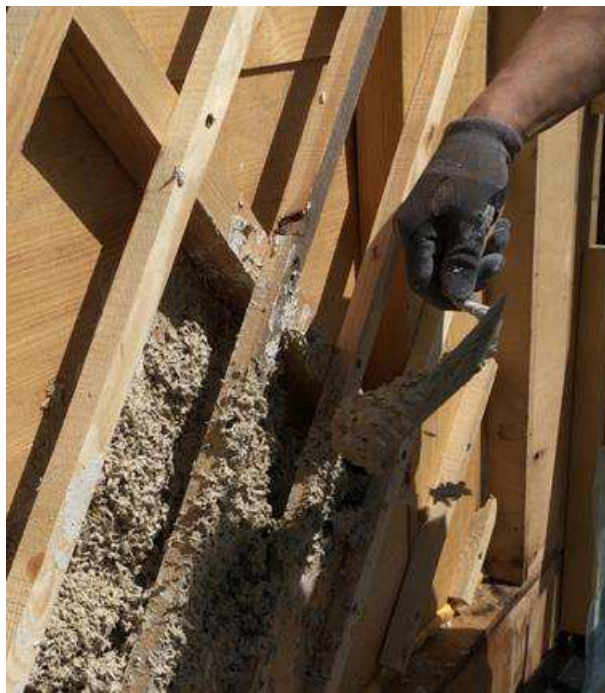
Figur 2. Hampakalk slås på en skiftesverksvägg. Foto: Paulien Strandberg-de Bruijn.
