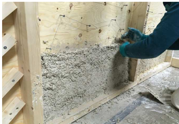
Figur 25. exempel på hur hampakalken kan fästas till underliggande konstruktion, med hjälp av befintliga ribbor eller med glest satt ståltråd. Putsnöt är i regel för tät för att det skall vara lätt att få in hampakalken bakom. Foto: Paulien Strandberg
