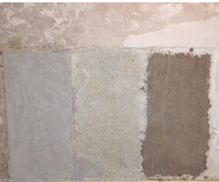
Figur 3. Första påslaget fick torka i ett par veckor innan ytputsen slogs på.
