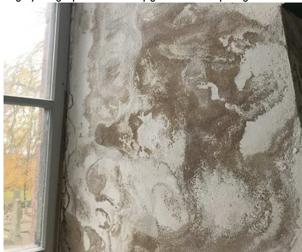
Figur 16. Saltrosor på cementputs. På en stark och tät puts syns sulfaterna som mörka saltrosor där färgen sprängts bort och putsen mörknat som vore den blöt.
