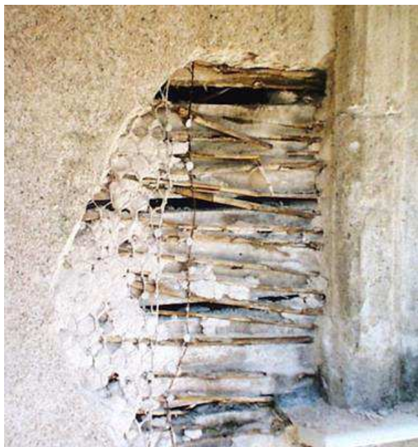
Figur 12. Rörning på spräckpanel som sattes upp på 1930-talet i Visby. Foto: Kristin Balksten
