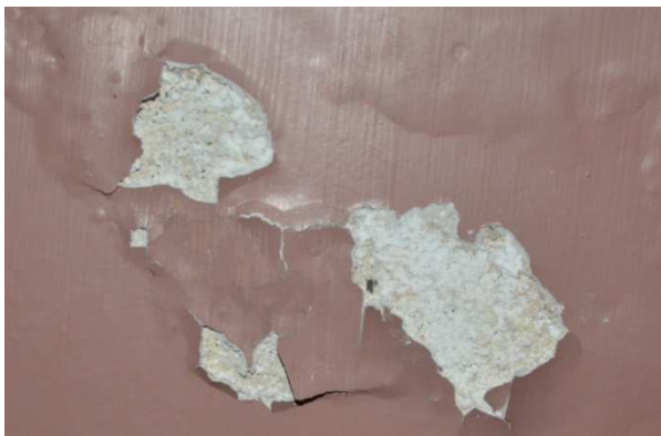
Figur 11. Sulfaterna känns igen genom att de ofta växer till strax under fasadytan – i synnerhet när ytan är målad med tät färg. Då lyfts ytskiktet och faller av och lämnar en något urgröpt muryta täckt av vita saltkristaller. Jämför med bild 12 där genomsläpplig färg löser upp sig och skadan blir ytlig.
