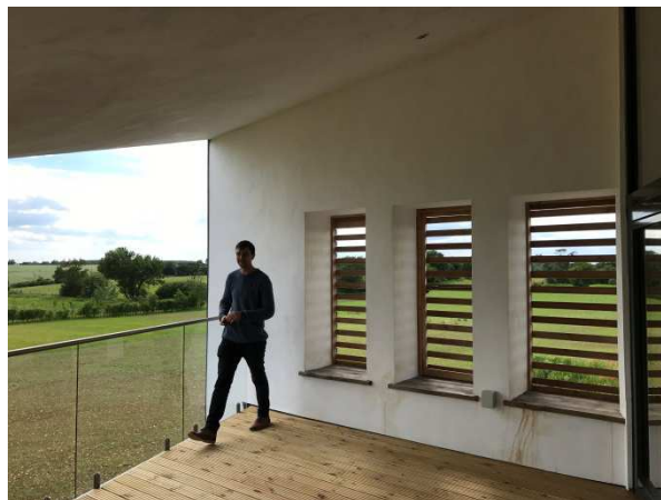
Figur 10-14. Clay Hill Farm i Lavenham, England som ritats av Modece Architects får representera ett spännande exempel på en modern hampakalkbyggnad där väggarna utgörs av hampakalk i regelstomme. Invändigt är hampakalken kalkputsad och utvändigt klädd med panel. Byggnaden har många spännande lösningar ur ett ekobyggperspektiv och är byggt för att både hus och natur ska hålla länge ( www.modece.com , 2017-07-01). Foto: Kristin Balksten
