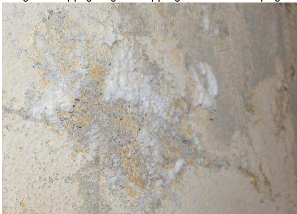
Figur 11. Sulfaterna känns igen genom att de ofta växer till strax under fasadytan – i synnerhet när ytan är målad med tät färg. Då lyfts ytskiktet och faller av och lämnar en något urgröpt muryta täckt av vita saltkristaller. Jämför med bild 12 där genomsläpplig färg löser upp sig och skadan blir ytlig.
