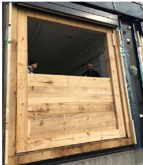
Figur 15. Bulhusvägg under uppbyggnad av HN Byggnadsvård och Kristoffer Fredriksen. Foto: Paulien Strandberg
