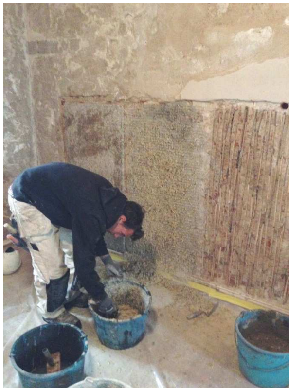
Figur 1. Tre provytor under tillverkning i Örgryte nya kyrka.
