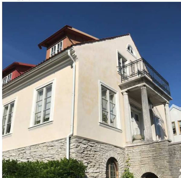
Figur 3-4. Ett traditionellt putsat bulhus med snedställda ribbor som bär putsen kan vid behov av omputsning få ett jämnare inomhusklimat och förbättrad energiprestanda genom att tillägga hampakalk mellan ribborna istället för tjock puts och ändå få samma typ av kompatibla konstruktion som tidigare, med bibehållen traditionell kalkputs och kalkfärg som värnar byggnadens kulturhistoriska värden.
