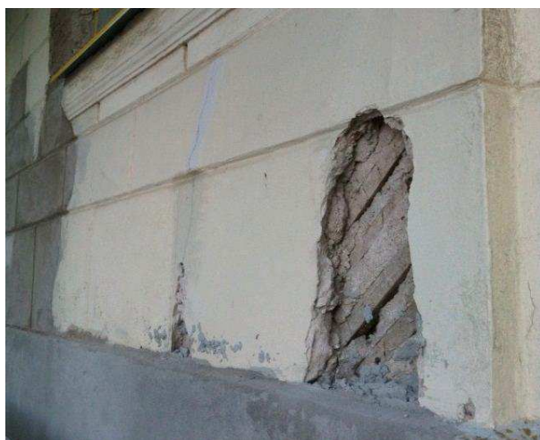
Figur 20. Lagning av kalkputs på ribbor. Lagningen utförs med KC-bruk utan fuktspärr. Risk för lokal framtida rötskada. Foto: Kristin Balksten
