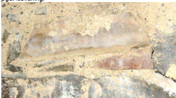
Figur 39. Ishinna som täcker en tegelsten invändigt i Tösse kyrktorn. På graniten har inte samma effekt uppstått utan det är från vattenmättat tegel som isen kunnat bildas.
