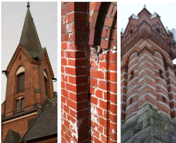
Figur 46. Skadorna är tydligt koncentrerade efter väderstreck.
