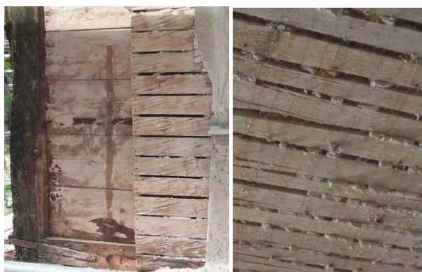
Figur 10. A) Spräckpanel som sattes upp på Silverhättan 1 i Visby på 1930-talet. På spräckpanelen syns spår av vassmattans rör. På bulhusstommen syns spår av äldre ribbning. Den rötskadade hörnstolpen var dold bakom en lagning av cementputs. B) Spräckpanel i tak som underlag för kalkputs. Foto: Kristin Balksten
