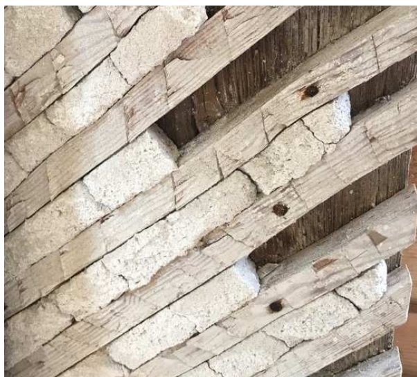
Figur 9. Tätt sittande råhuggna ribbor med puts emellan. Ribborna fäst vanligtvis diagonalt mot väggens plank eller timmer. Ofta är ribborna en aning koniska fästa med den bredare sidan utåt. Det ger mycket bra fäste för putsen. Ibland har mellanrummet också fyllts ut med exempelvis tegelskärvar. Foto: Kristin Balksten
