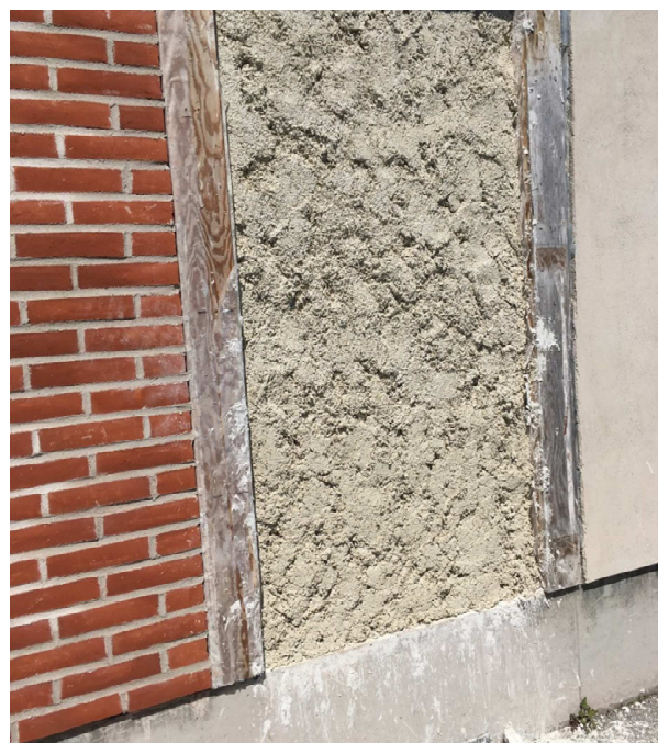
Figur 28. Utvändig tilläggsisolering av hampakalk under uppbyggnad. Till vänster; tegelvägg med invändig hampakalk.
