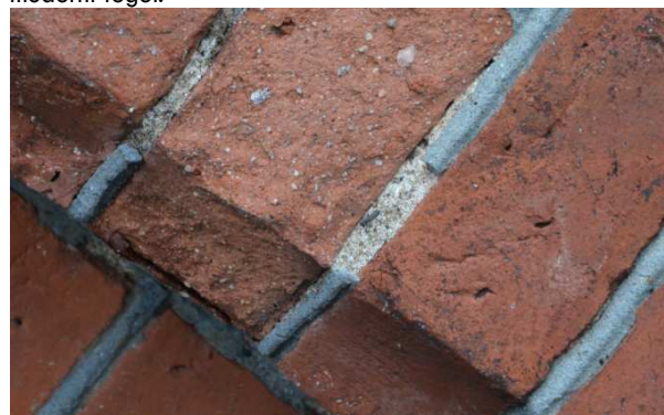
Figur 5. Dragen originalfog på Umeå stads kyrka. Den yttre cementfogen av gråpigmenterat bruk är ytterst tunn och ligger utanpå det ljusare kalkmurbruket.
