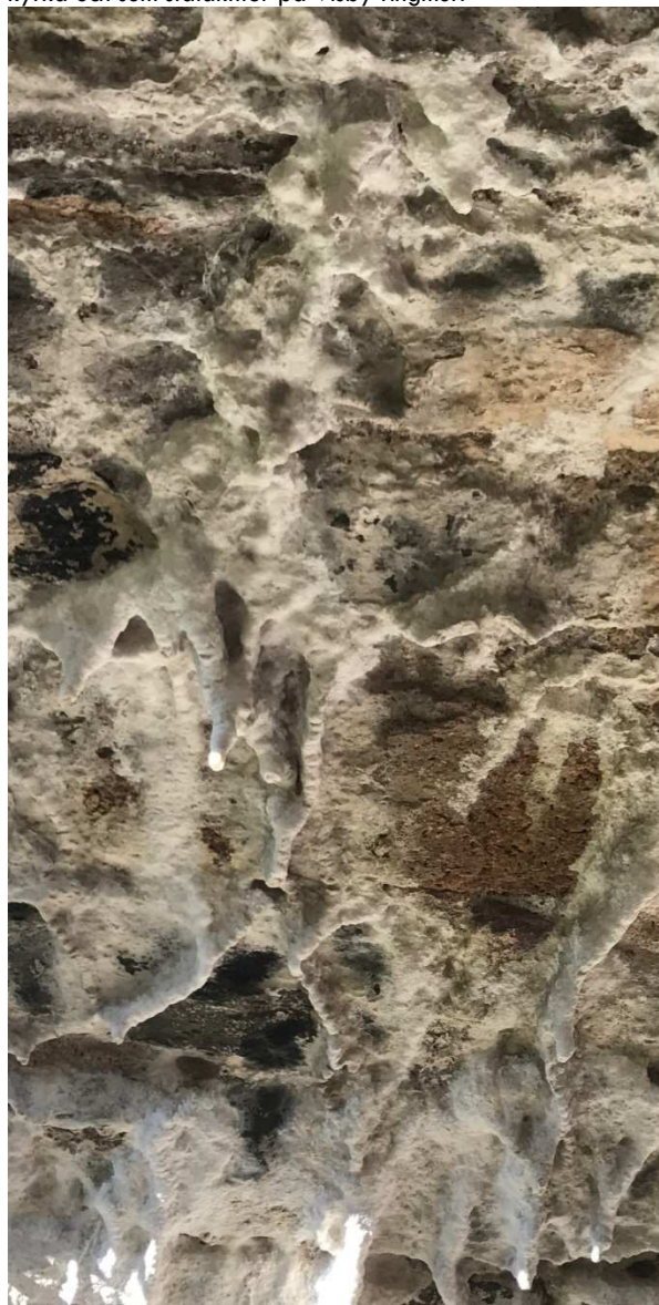
Figur 35-36. Kalk har frigjorts inuti ett murverk och avsatts som stalaktiter på ytan, här som floatstone på Lunds domkyrka och som stalaktiter på Visby ringmur.
