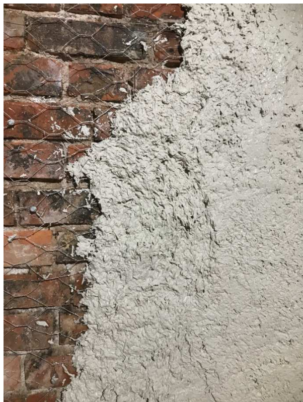
Figur 15. Där större putspartier görs om fästs ett grovmaskigt hönsnät med brickor och betongskruv som ett armerande och putsbärande alternativ. Hampakalken har här slagits på i tjocklek 2-3 cm direkt mot tegelväggen. Foto: Kristin Balksten
