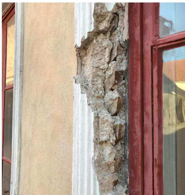
Figur 3-4. Ett traditionellt putsat bulhus med snedställda ribbor som bär putsen kan vid behov av omputsning få ett jämnare inomhusklimat och förbättrad energiprestanda genom att tillägga hampakalk mellan ribborna istället för tjock puts och ändå få samma typ av kompatibla konstruktion som tidigare, med bibehållen traditionell kalkputs och kalkfärg som värnar byggnadens kulturhistoriska värden.
