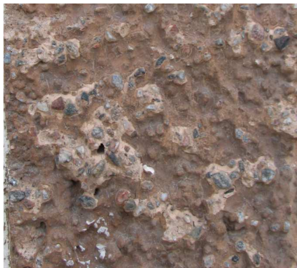
Figur 19. Närbild på en infärgad kalkcementputs där ytskiktet har förgipsats. Det innebär att ytan upplevs som mycket smutsig och benägen att skikta sig. Under ytskiktet syns originalkulören.
