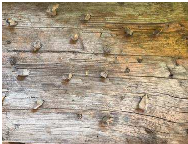
Figur 8. Små träpliggar omkring 5 cm långa slås in väggarna, för att putsen ska ha något att fastna på. Pligging är en bättre metod än råhuggning när ett kalkbruk används. Foto: Kristin Balksten
