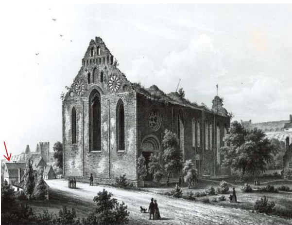
Figur 4. På denna bild av P-A Säre från 1858 syns det då troligen nybyggda huset på Biskopen 5. Observera att gavelspetsen är oputsad, av resvirke och att den endast har en liten fönsterglugg. Troligt är att taket var täckt av falor och först senare fick tegel. Den lätta mansardformen på taket syns tydligt och har alltså funnits från början. Skorstenen är placerad på husets norra takfall. Byggnaden har en ovanlig placering med gaveln mot gatan.
