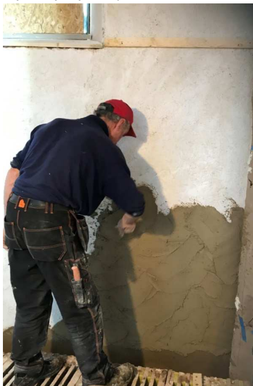
Figur 21. Ytputsen har här gjorts av ett infärgat kalkbruk som appliceras direkt på hampakalken, vilken har god sugförmåga som ger bra vidhäftning. Foto: Kristin Balksten
