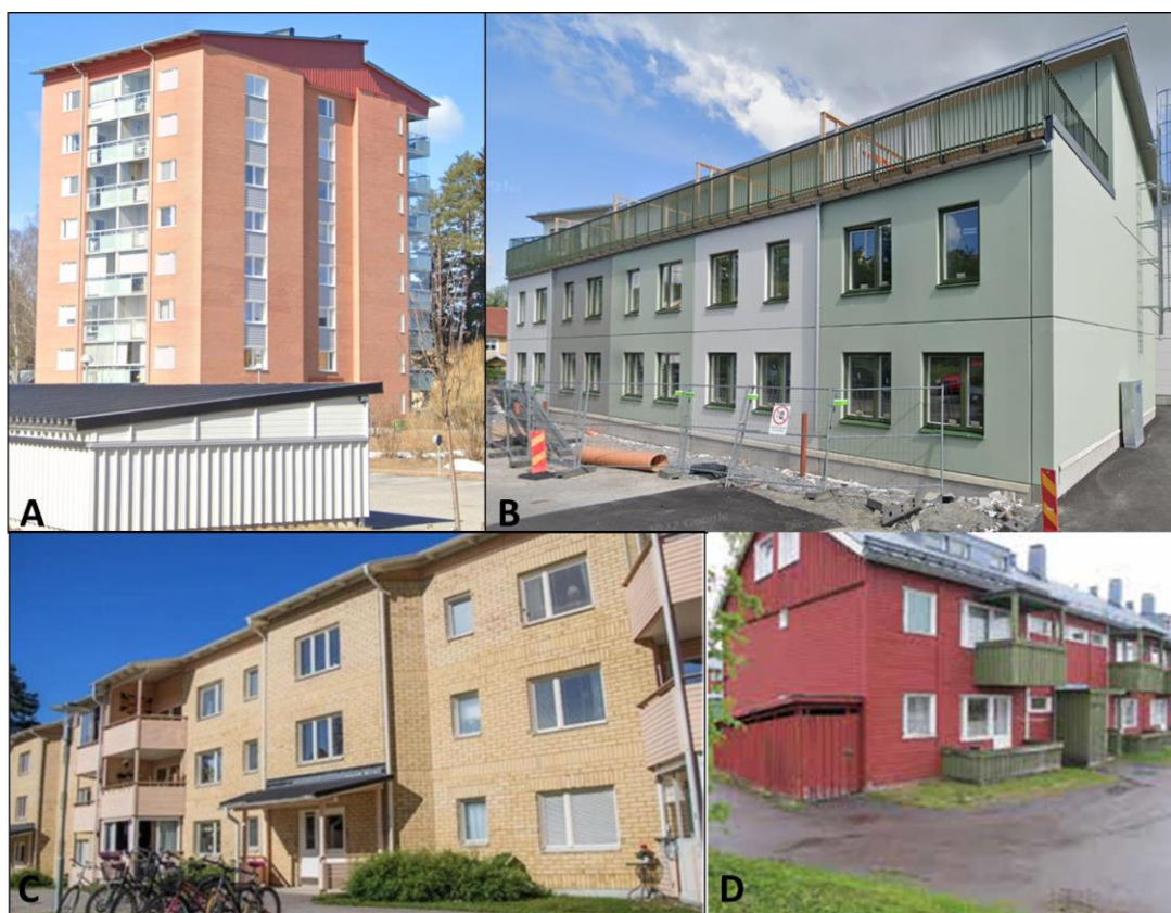
Figur 2. Fallstudier som undersöktes i forskningsprojektet: (A) nybyggt punkthus från NCC, (B) nybyggt radhus från Skanska, (C) befintligt 1980-tals bostadshus från Pitebo och (D) befintligt 1970-tals bostadshus från Kirunabostäder.
