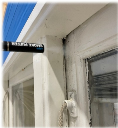
Bild 4 Provning av lufttätet med hjälp av gas. Fönster från Helleforsgatan.
