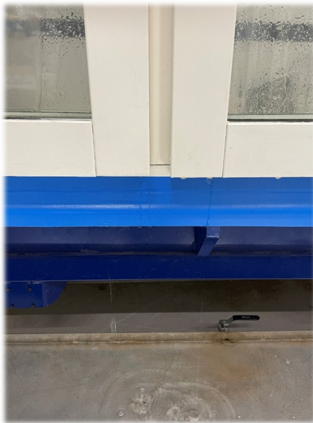
Bild 5 Provning av regntäthet. Fönster från Oxholmsgatan.
