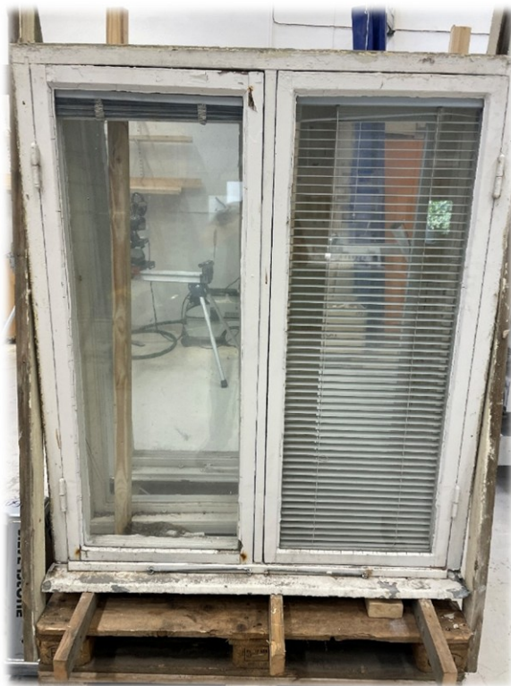
Bild 1 Fönster från Helleforsgatan har tagits emot i RISE laboratorium i Borås
