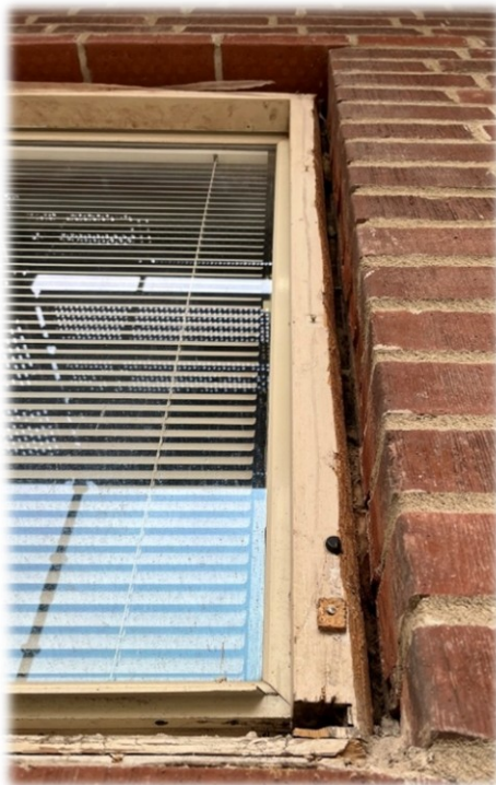
Bild 3 Bilden visar sanerat fönster på Gåsagången
