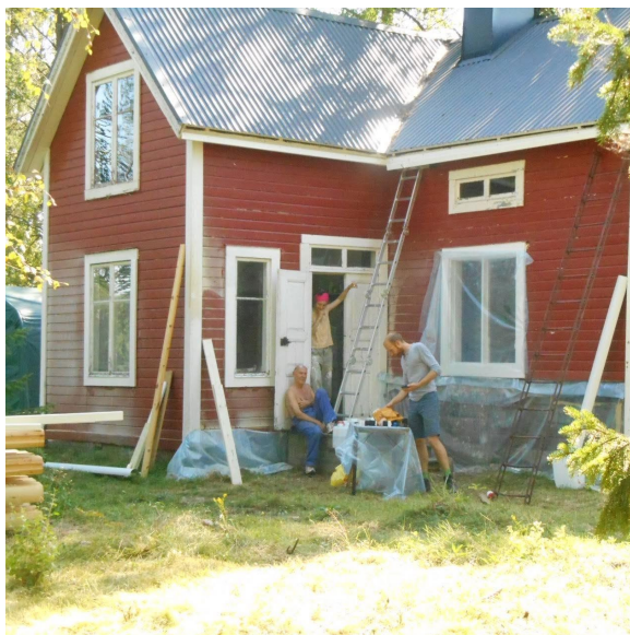
Figur 8. Exteriör för villan under pågående renoveringsprocess.
