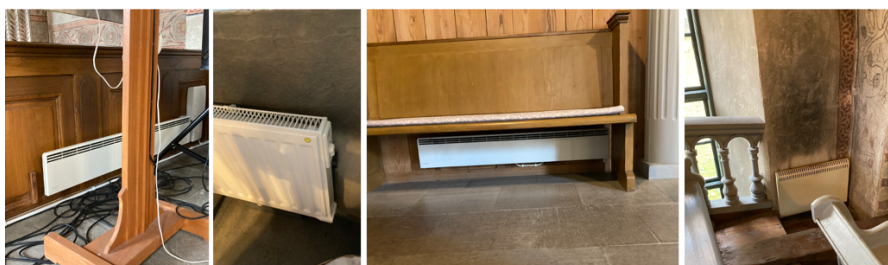
Figur 37 Exempel på olika elradiatorer i kyrkan.
