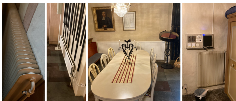
Figur 33 Exempel på radiatorer av olika ålder i Länna kyrka.
