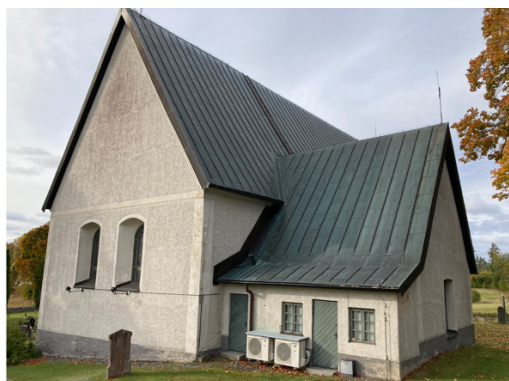
Figur 36 Utedelar till luft-luft-värmepumpar.
