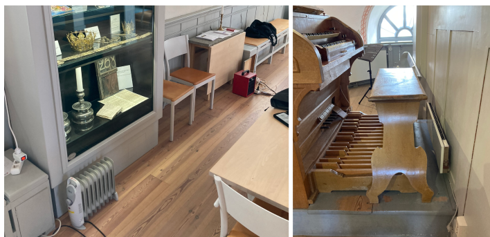
Figur 31 Mobil radiator och värmefläkt i kyrksalen samt äldre elradiator på orgelläktare.
