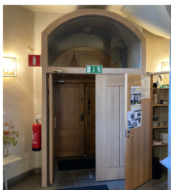
Figur 21 Luftsluss har byggts för att minska drag från porten i Norrtälje kyrka (till vänster)
