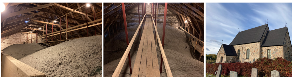
Figur 16 Vindsisolering i Roslagsbro kyrka där valven isolerats.
