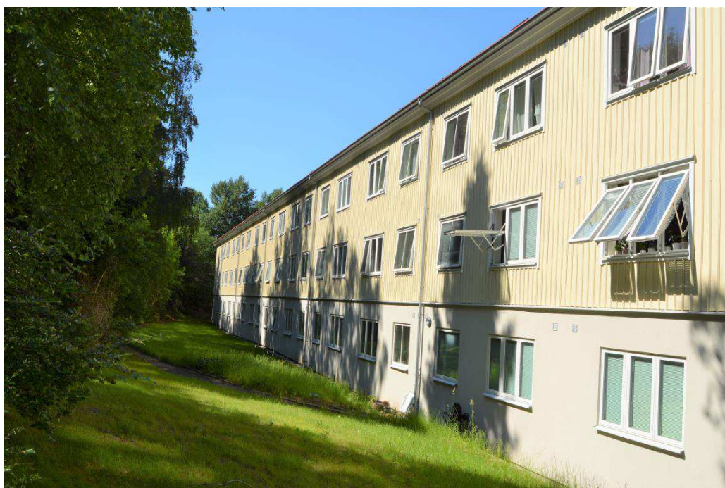
Figur 25. Nya pivothängda fönster på renoverad fastighet, fall/område A. Foto Lina Askemyr and Hanna Holmkvist, 2018.
