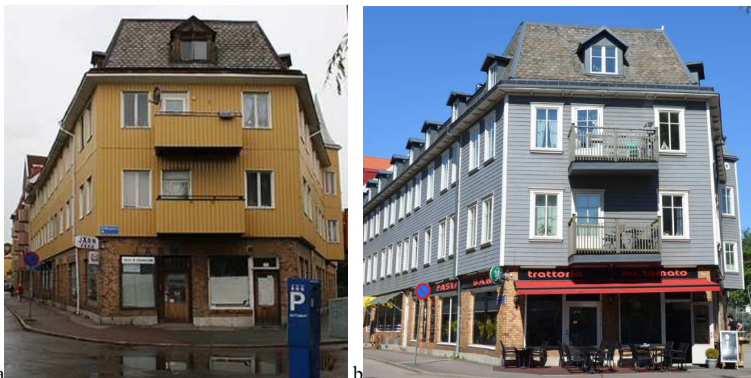
Figur 16. Till vänster foto på byggnaden med den gula plåtsfasaden före om-renoveringen (foto: Jesper Hallén, 2009). Till höger efter om-renoveringen med återställd träfasad 2018.
