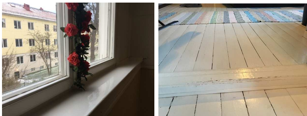
Figur 23. Interiöra detaljer som uppskattas. Till vänster gamla fönster som finns kvar i en byggnad i område A och till höger, ett slipat trägolv från fall B.
