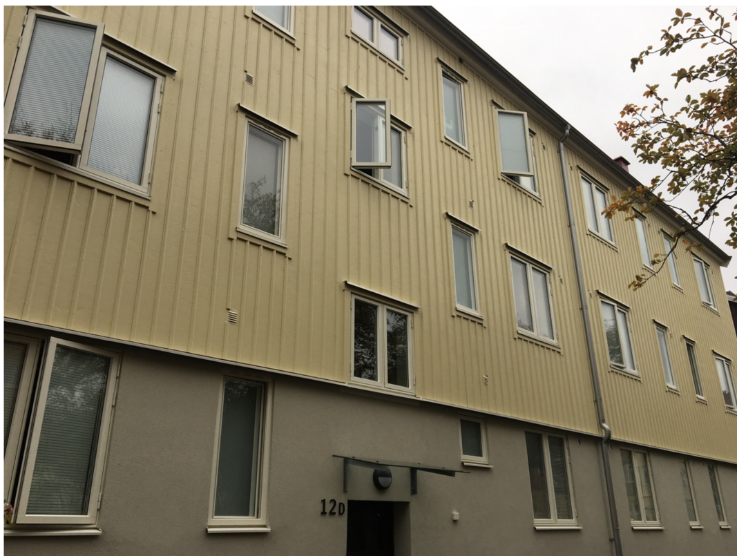
Figur 13. En ny fas av om-renovering färdigställd efter vår studie där man använt sig av sidohängda utåtgående fönster för ett utseende som i högre grad liknar det ursprungliga. Foto från 2018.
