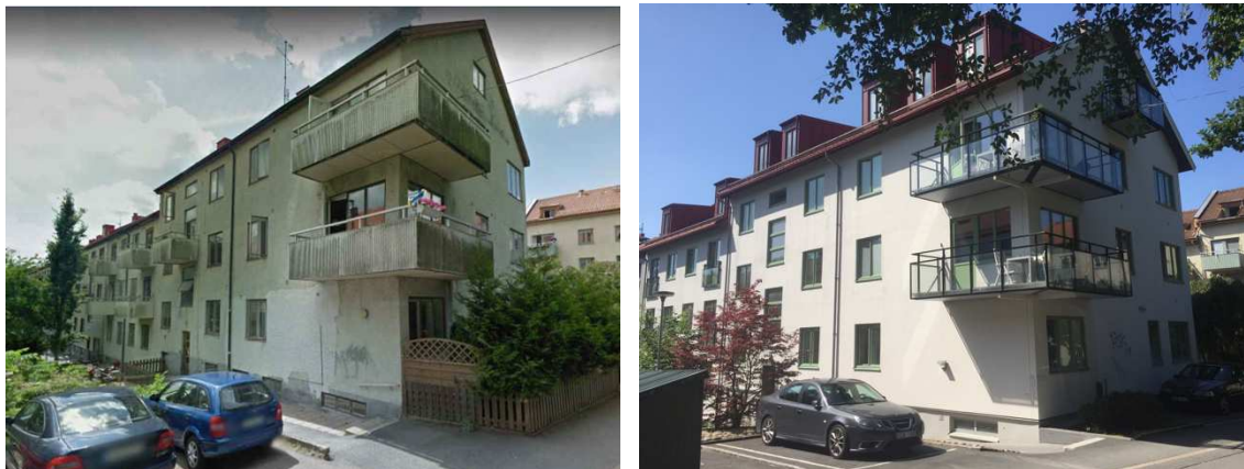
Figur 21. Bilder från fastighet C mot gården, före renoveringen (till vänster) och efter (till höger). (Foto från före renoveringen från Google streetview)
