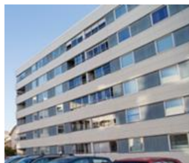
Fasad mot sydost
