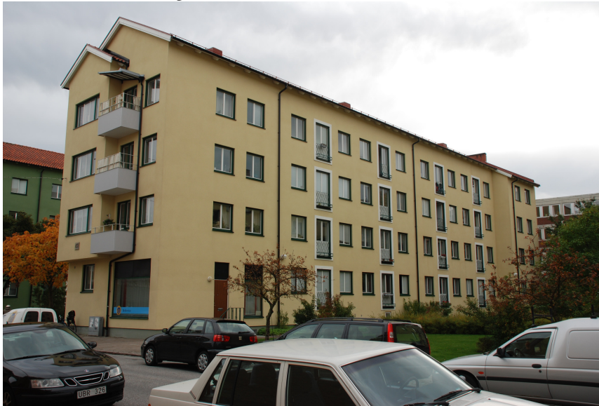
Figur 8.1 Brf Ryttmästaren (Malmö) efter tilläggsisolering av fasad.
