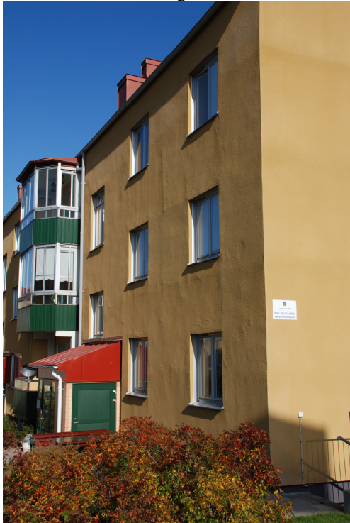
Figur 8.8 Brf Huggaren (Malmö) efter tilläggsisolering av fasad.
