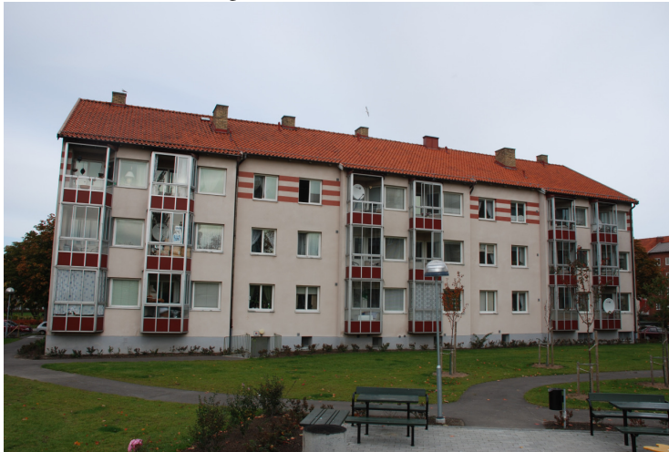
Figur 8.12 Fastigheten Hösten (Malmö) efter tilläggsisolering av fasad.
