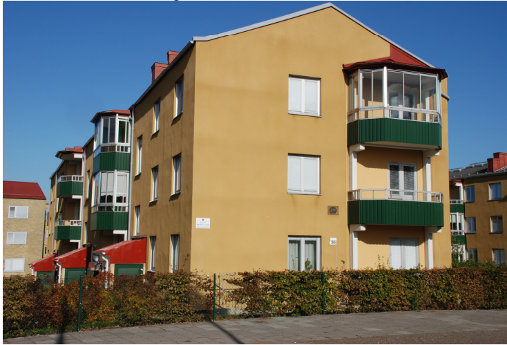
Figur 8.7 Brf Huggaren (Malmö) efter tilläggsisolering av fasad.
