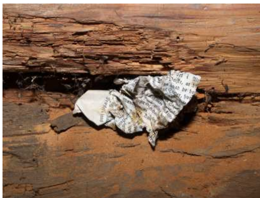
Foto 10. Röttskadat virke som har blivit tätat mot drag med tidningspapper med gotisk skrift, visar att detta blev gjort för mycket länge sedan.
