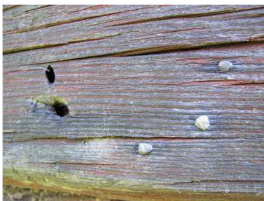
Foto 10. Om hålen är tätade med jord, betyder det att det har varit en sekundär aktivitet av solitära bin som har utnyttjat de gamla hålen utan att utveckla ytterligare skada av virket.
