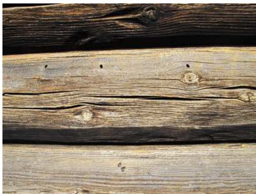
Foto 8. Utflygningshål i en timmervägg betyder inte automatiskt att det är ett problem.
