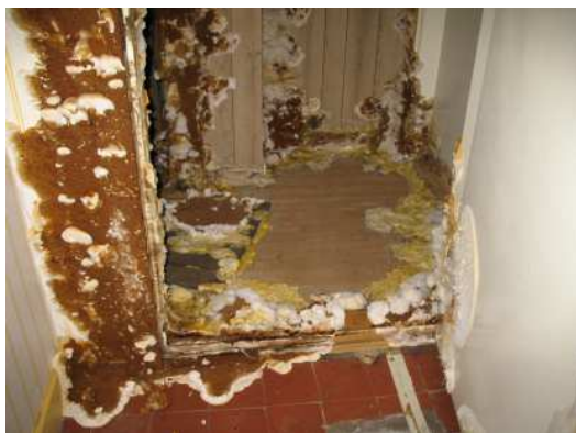
Foto 7. Ett angrepp av äkta hussvamp som har utvecklats nya fruktkroppar är självklart aktiv, men hur gammalt och omfattande är egentligen angreppet? Varför uppstod den nya utvecklingen av det gamla angreppet?
