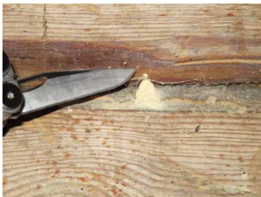
Foto 6. Högar med bormjöl betyder inte att det är speciell aktivitet av strimmig trägnagare, men av en del naturliga fiender (andra insekter) som jagar och äter upp larver till strimmig trägnagare - dvs. ett gott tecken!
