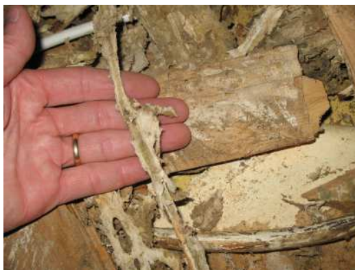
Foto 8. Detaljer i hur svampen ser ut i golv och väggar ger viktig information om skadans ålder. Tjockt strängmycel till äkta hussvamp visar att skadan är utvecklad under många år.
