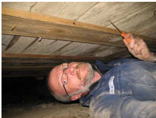
Foto 3. Det är viktigt att undersöka de delar av huset som det är mest troligt att skador förekommer, men i många tillfällen är de svåråtkomliga.
