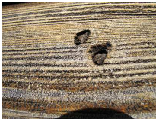
Foto 20. Om hålen är fyllda med gammal tjära betyder det att det inte har varit någon aktivitet i virket på många år.
