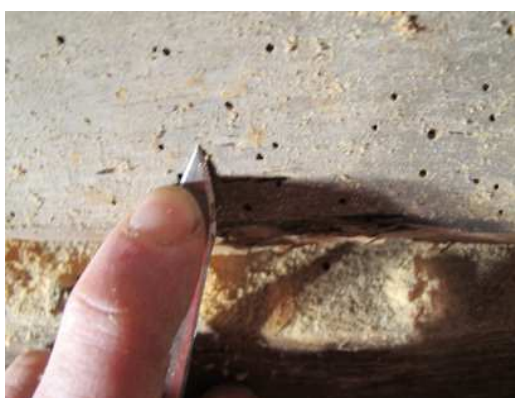
Foto 5. Är det begränsade skador av strimmig trägnagare efter många år, har man god tid på sig till att följa med på eventuell skadeutveckling innan det är behov för att bestämma sig för några åtgärder.
