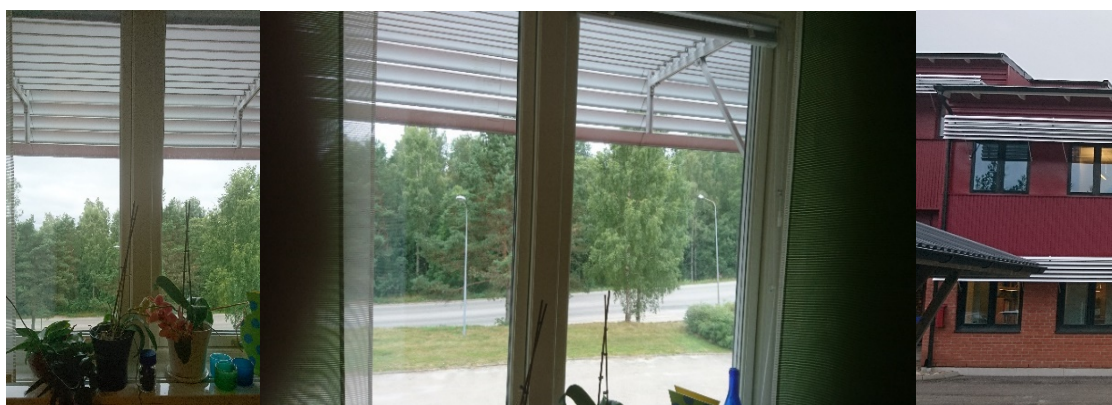
Figur 6 Den ordinarie solavskärmningen på RISE kontorsbyggnader består av aluminiumlameller i ett horisontellt och vertikalt arrangemang. Utsikt från sittande och stående vid skrivbordet.
