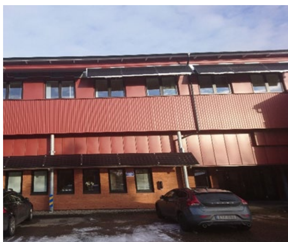
Figur 9 Under tidig vår och sen höst när solen står lågt på himlen är de fasta avskärmningarna inte särskilt effektiva som avskärmningar om de också ska medge god utsikt och dagsljusinsläpp.
